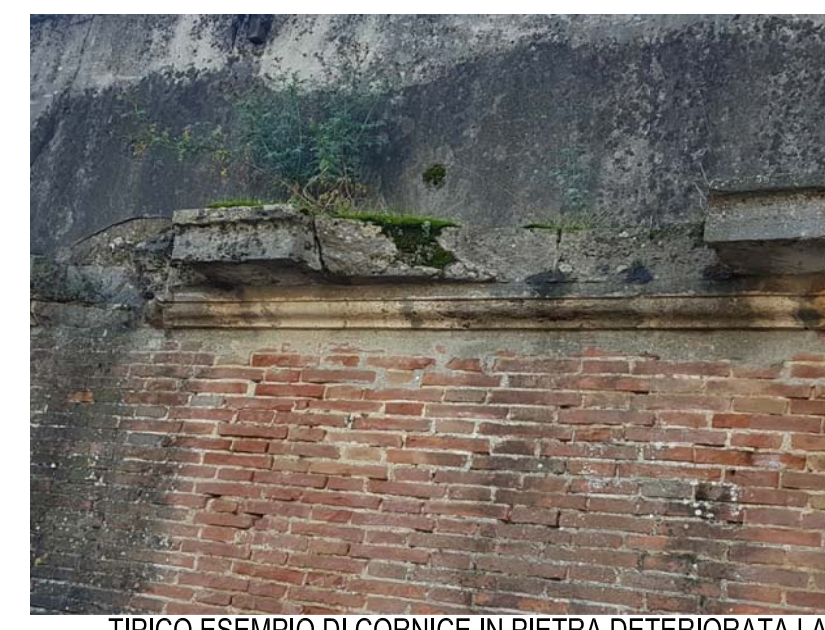
TIPICO ESEMPIO DI CORNICE IN PIETRA DETERIORATA LA PREVISIONE OLTRE CHE ALLE OPERE DI RIPULITURA, ELIMINAZIONE PIANTE INFESTANTI, MUSCHI LICHENI E' QUELLA DELLA SUA RICOSTRUZIONE CON MALTE POZZOLANICHE
