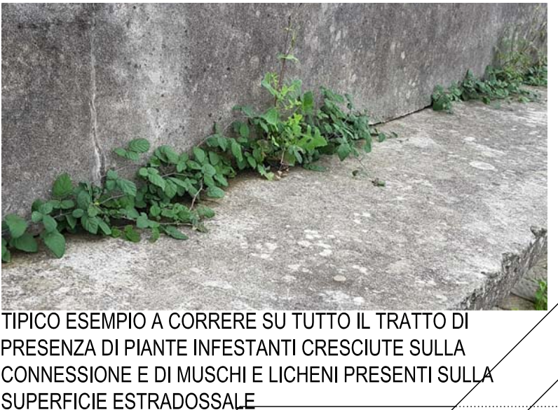
TIPICO ESEMPIO A CORRERE SU TUTTO IL TRATTO DI PRESENZA DI PIANTE INFESTANTI CRESCIUTE SULLA CONNESSIONE E DI MUSCHI E LICHENI PRESENTI SULLA SUPERFICIE ESTRADOSSALE
