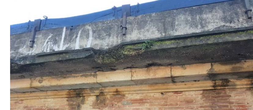
ALTRO ESEMPIO DI "INCISIONE" TIPICO DI TUTTI I TRATTI IL PROGETTO PREVEDE LA RICOSTRUZIONE DELLE PORZIONI MANCANTI CON STESSA TIPOLOGIA COSTRUTTIVA
