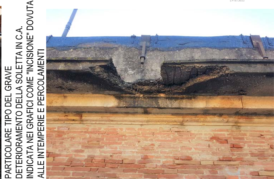
PARTICOLARE TIPO DEL GRAVE DETERIORAMENTO DELLA SOLETTA IN C.A. INDICATA NEI GRAFICI COME "INCISIONE" DOVUTA ALLE INTEMPERIE E PERCOLAMENTI
