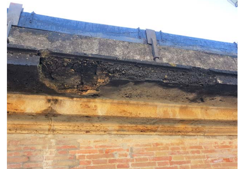
ALTRO ESEMPIO DI DETERIORAMENTO DELLA SOLETTA PER QUESTE PORZIONI SI E' PREVISTA LA DEMOLIZIONE E IL RIFACIMENTO VEDI TRATTI INDICATI IN ROSSO
