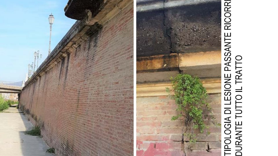
TIPOLOGIA DI LESIONE PASSANTE RICORRENTE DURANTE TUTTO IL TRATTO
